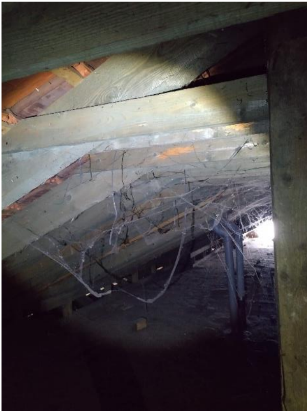
Abbildung 14 Dachbalken mit Spinnweben auf dem Dachboden
