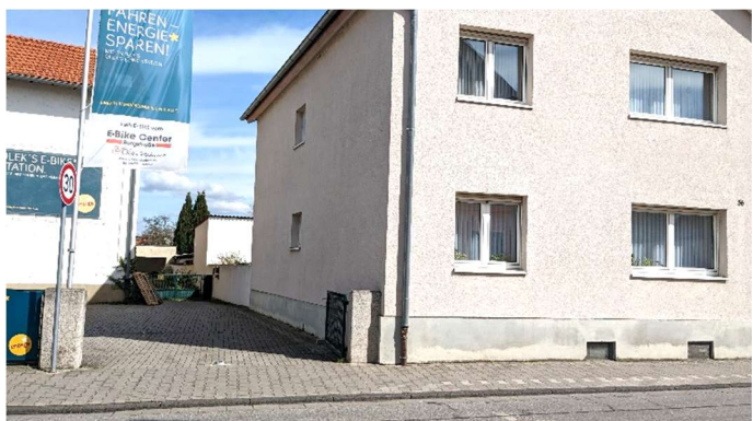
Abbildung 5: Gepflasterter Fußgängerweg mit Einfahrtsbereich Mathildenstraße 54
