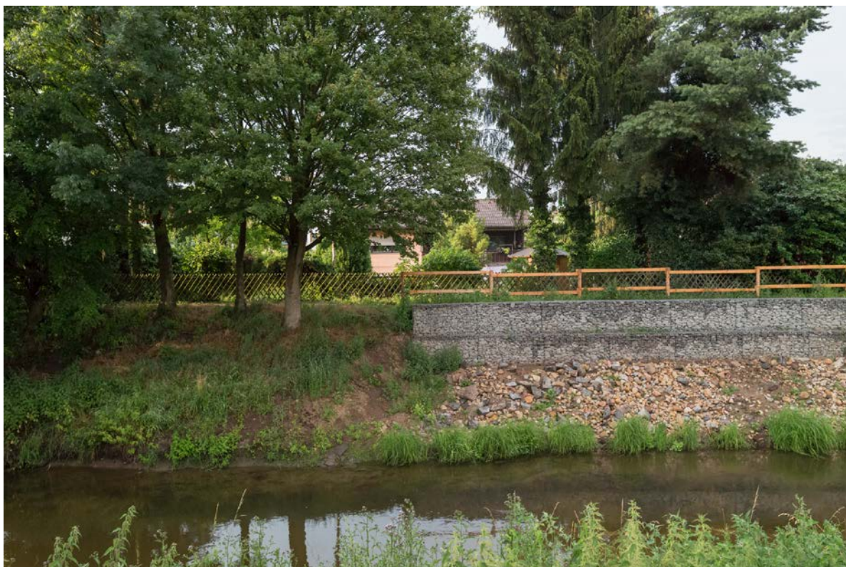
Befestigter Uferbereich der Weschnitz. Foto: Steffen Diemer / NH ProjektStadt
