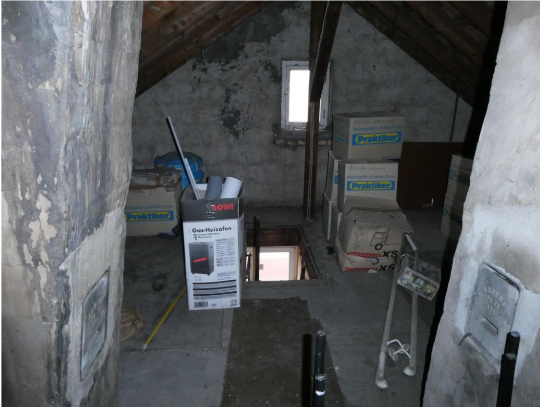
Abb. 13: Dachraum von Nr. 20
