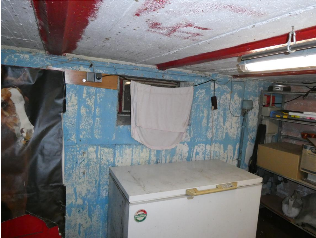
Abb. 17: Kellerraum von Nr. 20 mit verglastem Kellerfenster, Beispiel
