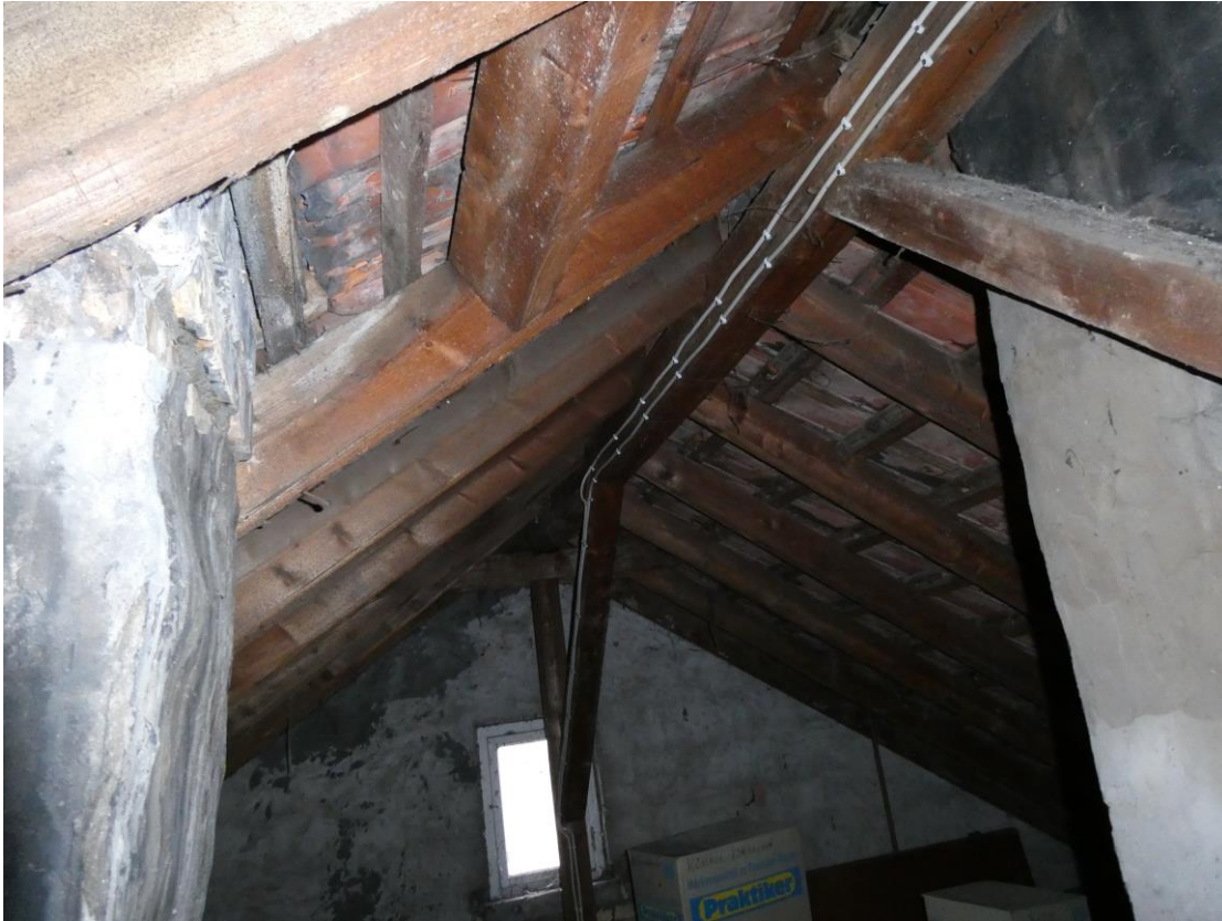
Abb. 15: Dachgebälk von Nr. 20
