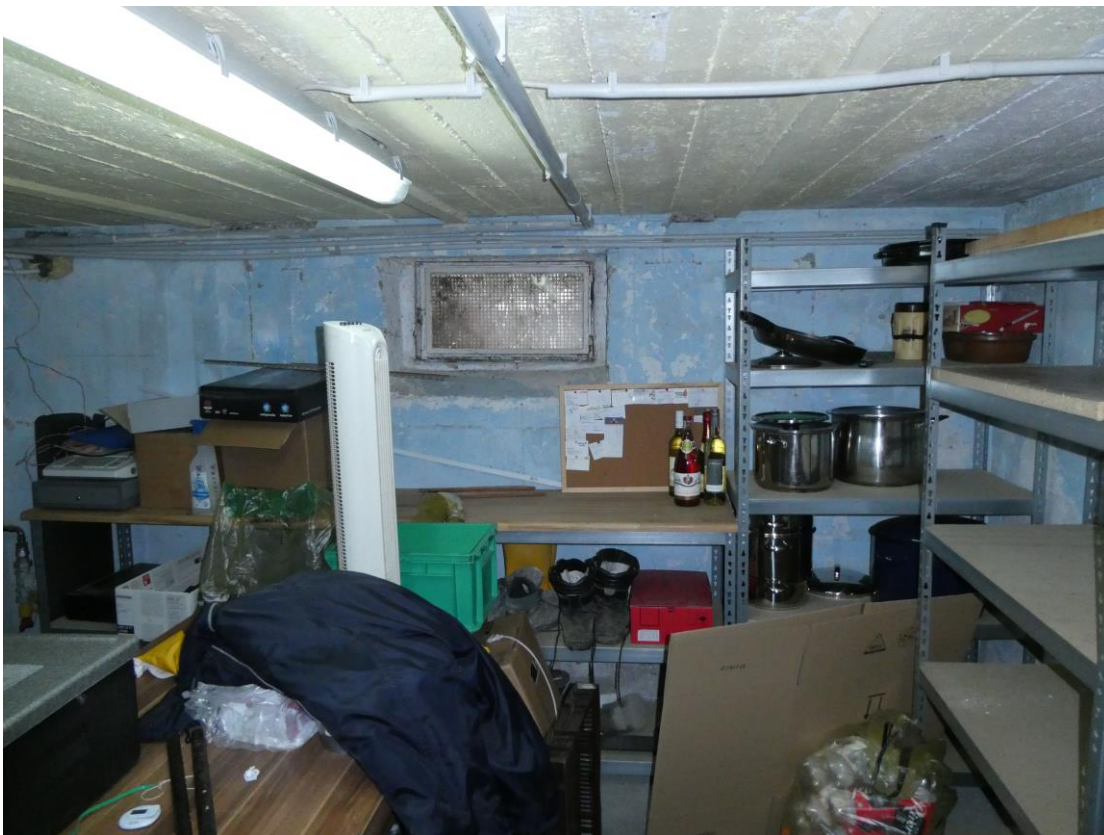
Abb. 12: Kellerraum mit verglastem Kellerfenster, Beispiel
