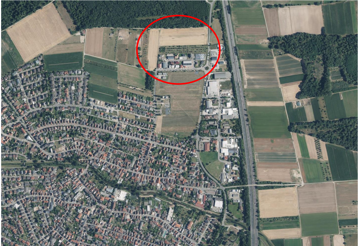
Abbildung 14: Luftbild des Plangebiets und der Umgebung (unmaßstäblich; Bildquelle: Hessische Verwaltung für Bodenmanagement und Geoinformation, Stand vom 08.07.2019)
