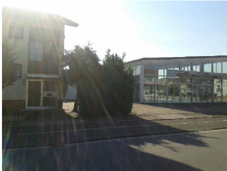
Foto 3: Planareal Waldstraße 54 – 56 (Ansicht von der Waldstraße)
