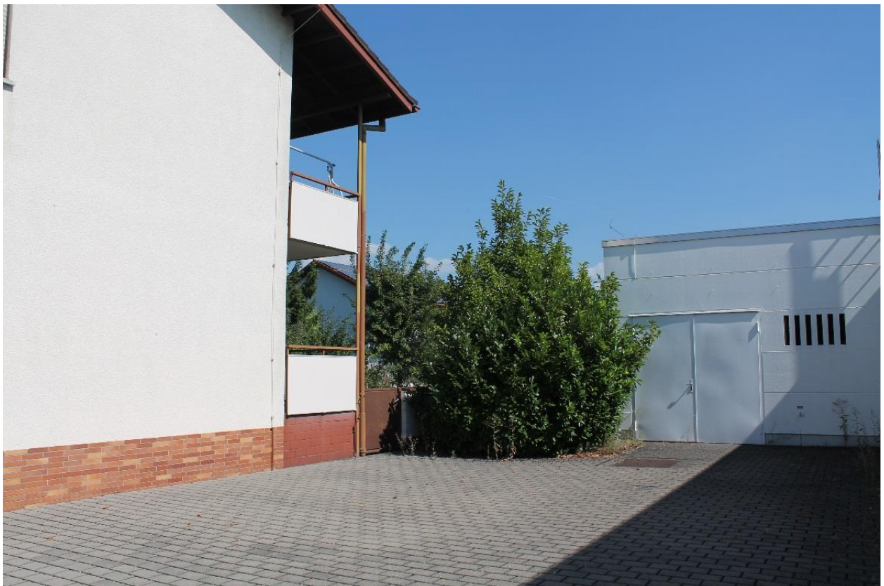
Abbildung 13: Blick von der Waldstraße auf Wohngebäude Nr. 54 und gewerblich genutztes Gebäude Nr. 56
