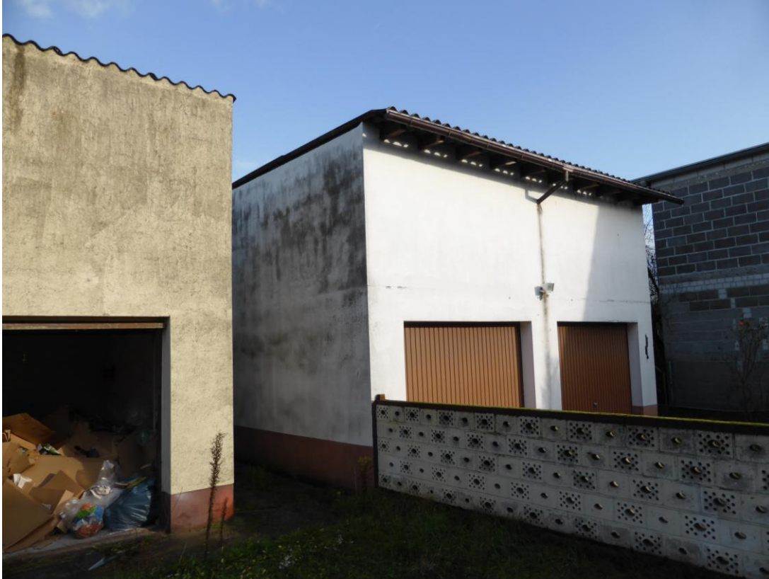
Abb. 2: Nebengebäude von Nr. 46 (links) und 48. Keine Hohlräume unter der Dacheindeckung
