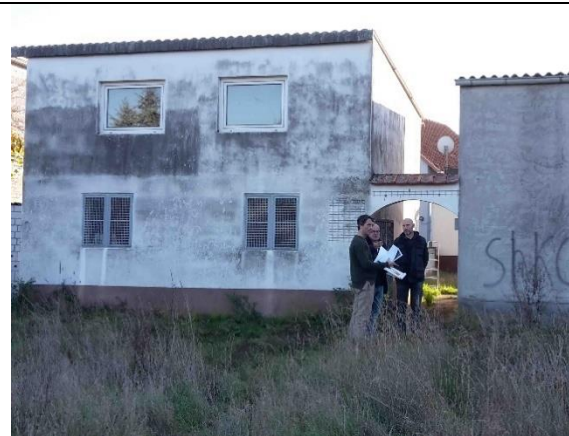
Foto 6: Rückseite Nebengebäude Mathildenstraße Nr. 46 und Nr.48
