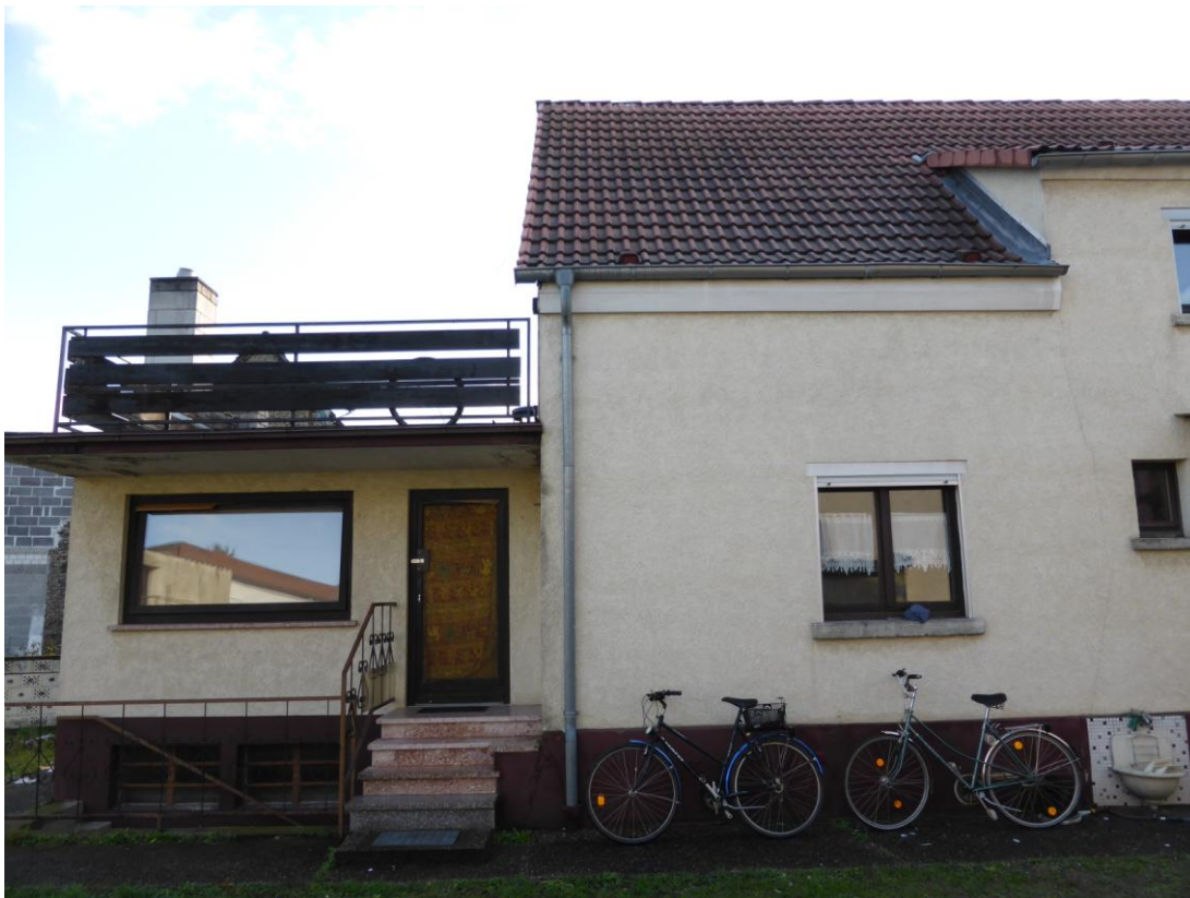
Abb. 1: Haus Nr. 46, keine Hohlräume / Nistmöglichkeiten unter dem Dachtrauf
