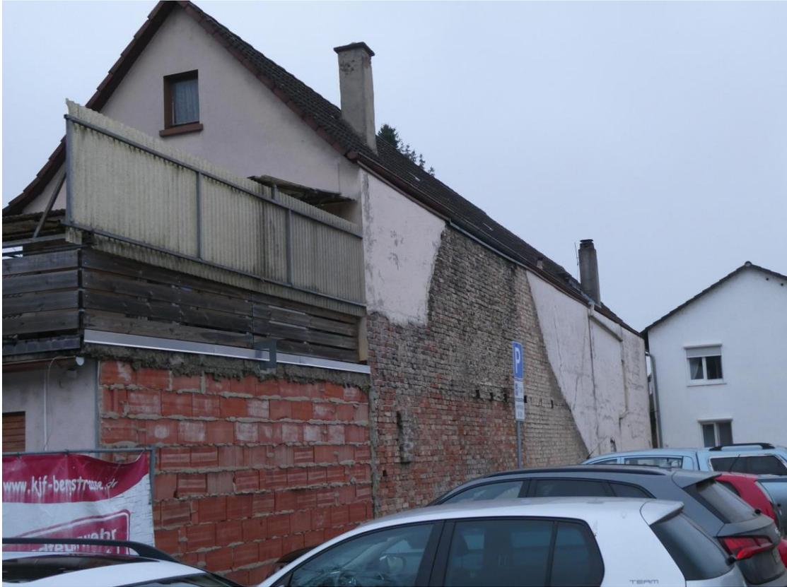
**Abb. 8:** Unverputzte Seite zum Nachbargrundstück mit schmalen Mauerspalt
