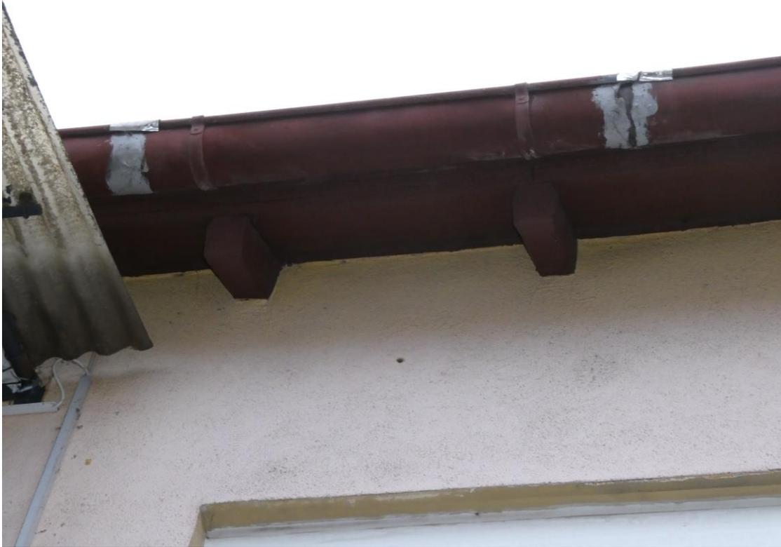
**Abb. 4:** Dachanschluss ohne Spalten und Einflugmöglichkeiten
