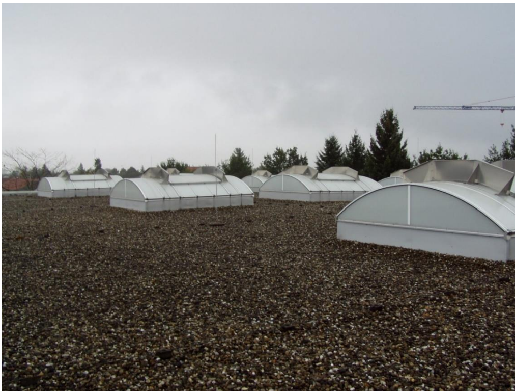
Abbildung 7: Unsaniertes Hallendach ohne PV im Jahr 2014
