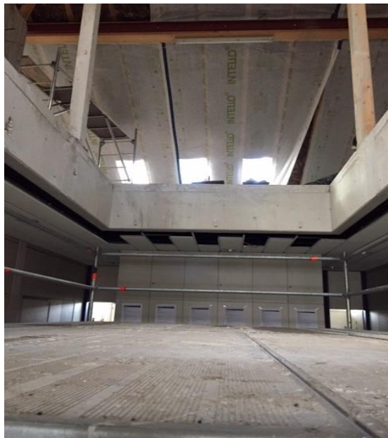
Abbildung 2: Durchbruch zum Dachgeschoss im Jahr 2018
