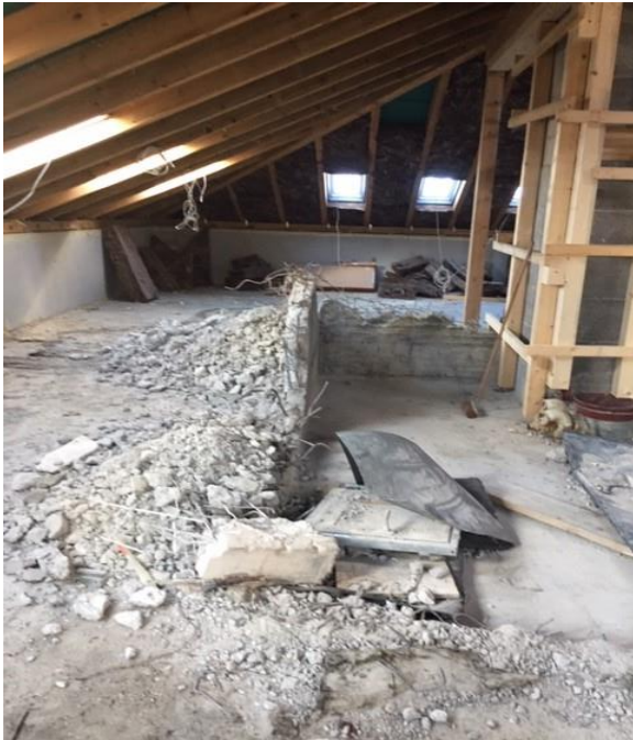
Abbildung 1: Abrissarbeiten im Dachgeschoss im Jahr 2018
