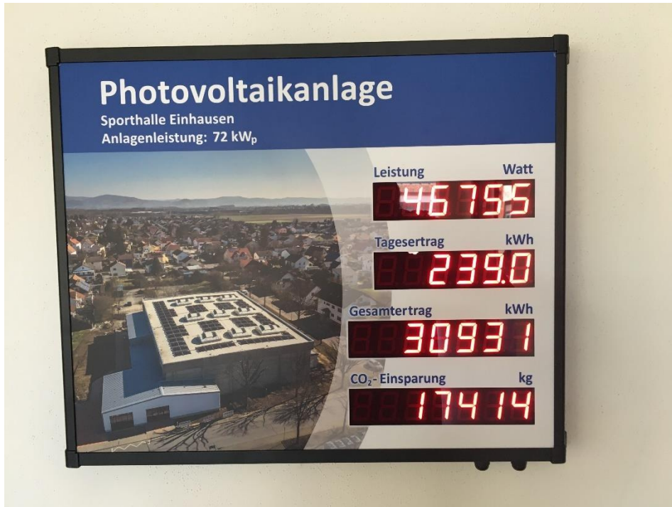
Abbildung 84: Anzeigetafel der PV-Anlage mit Leistungsanzeige
