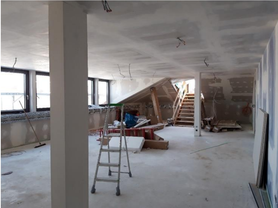
Abbildung 3: Trockenbau mit ersten Elektro-Installationen im Jahr 2018
