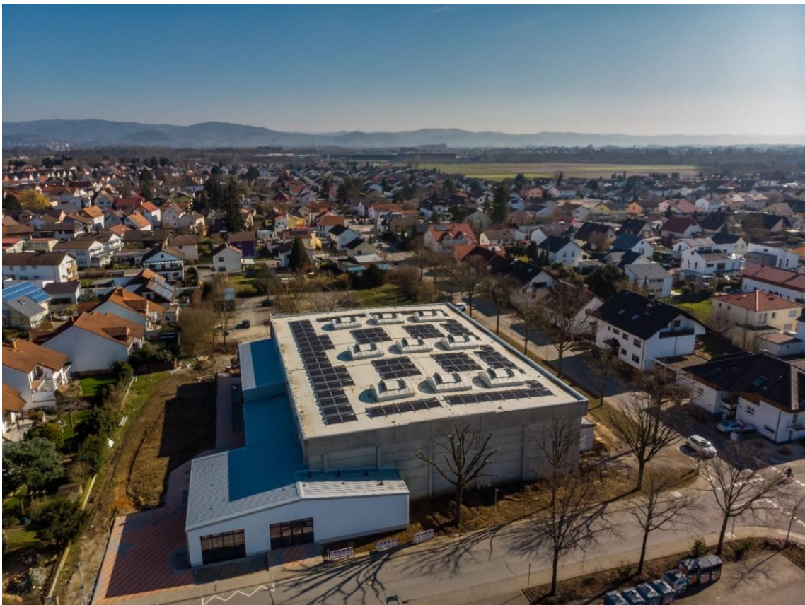
Abbildung 9: Energetisch sanierte Dachfläche und PV-Aufständerung mit 72 kWpeak (2017)
