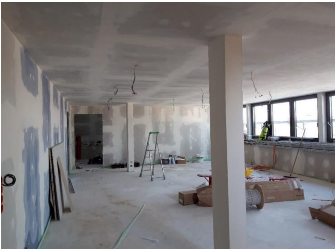
Abbildung 4: Trockenbau mit ersten Elektro-Installationen II im Jahr 2018
